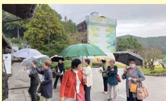
改修中の瑠璃光寺五重塔
